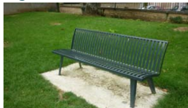
Dalle béton sous les mobiliers
